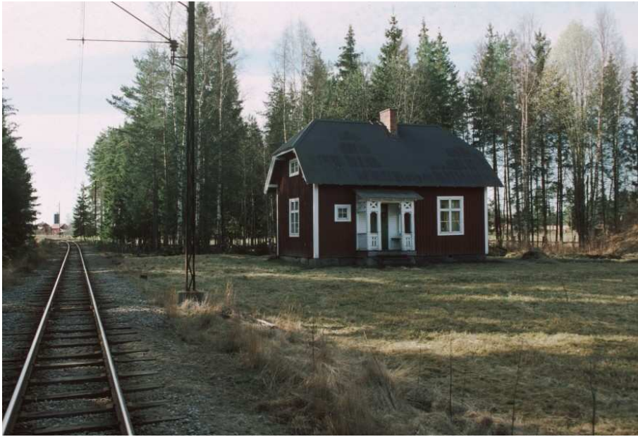
Banvaktstuga vid Karlstad-Munkfors järnväg (KMJ).
