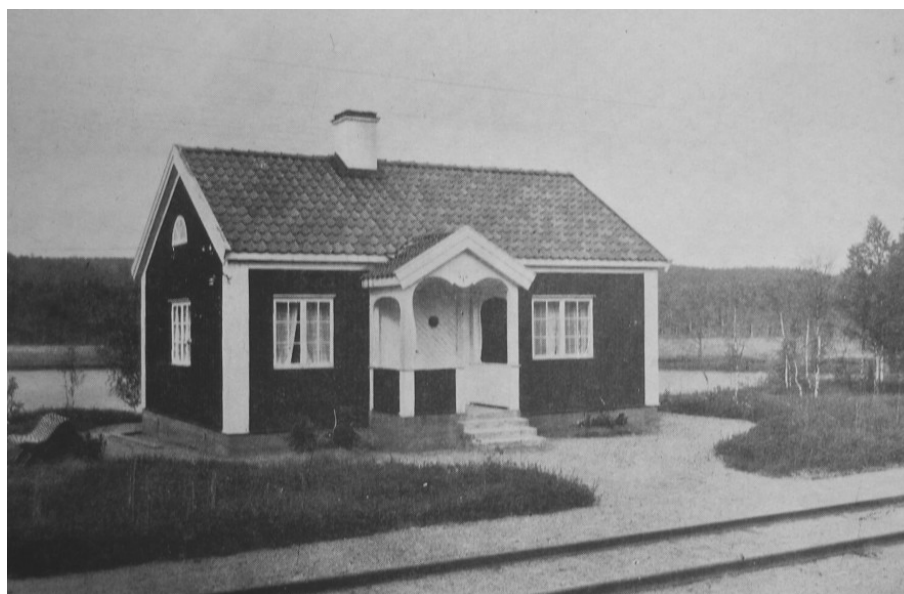
Banvaktstuga vid Nora Bergslags järnväg (NBJ).
