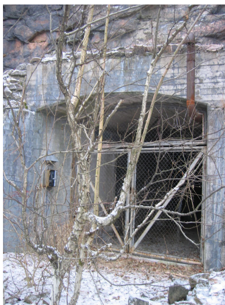
Figur 44 Gången som mynnar ut i berget bakom fjärrställverksbyggnaden
