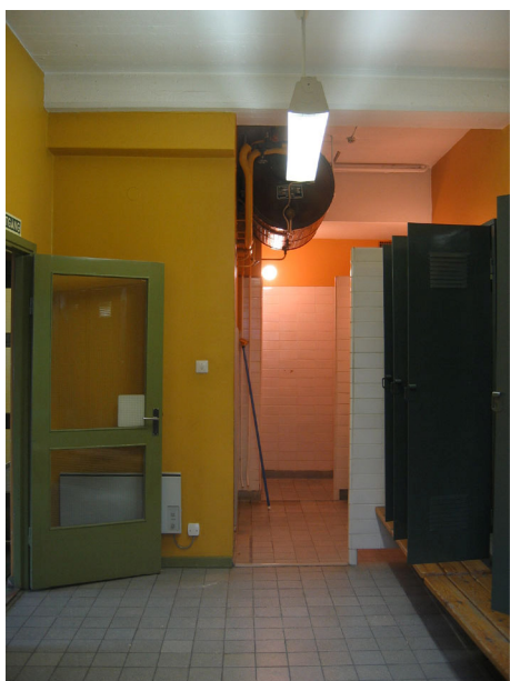
Figur 25 Omklädningsrummet 106A med duschen i bakgrunden.
