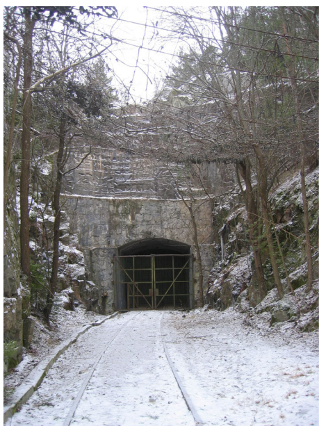
Figur 43 Porten till maskinsalen med det grovmaskiga nätet ovanför.
