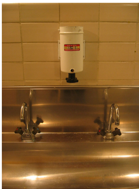
Figur 26 Detalj från det långa tvättstället i duschrum 106B.
