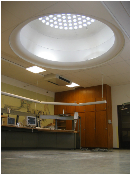
Figur 30 Kupolen med glasbetong.
