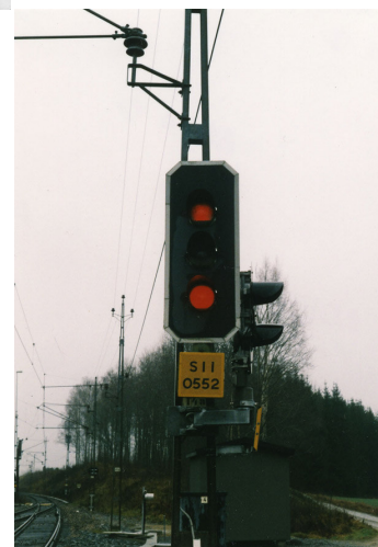
Figur 5 Signal 0552 i Silinge med den för TGOJ typiska rektangulära bakgrundsskärmen. Bilden är tagen strax före utbytet av Siemens anläggningar på sträckan Flens övre–Oxelösund. Till höger syns den nya signal enligt Banverkets standard med rundad skärm som snart ska ersätta den gamla.
