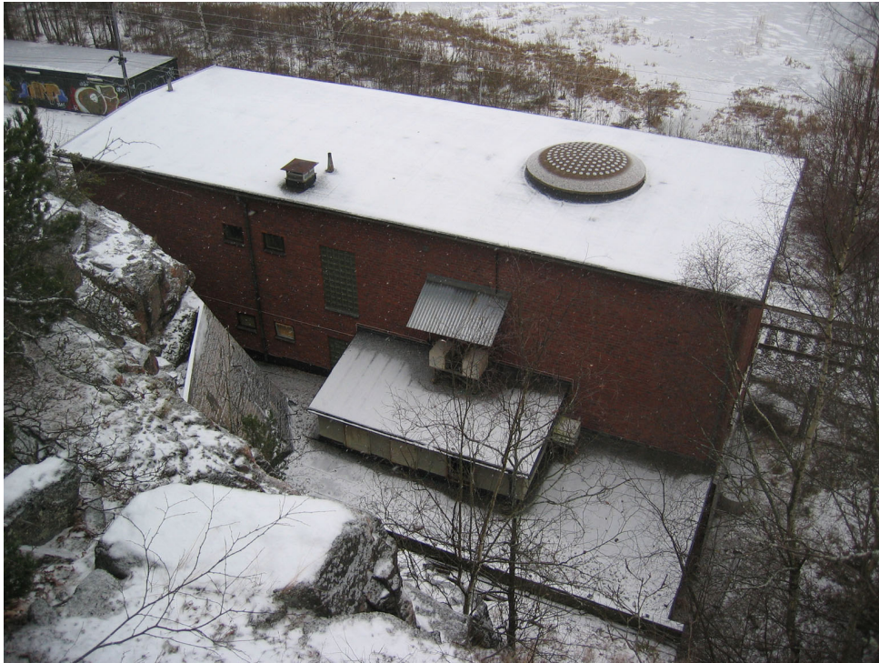
Figur 11 Fjärrställverksbyggnaden sedd från nordväst med glasbetongkupolen och utbyggnaden mot berget.
