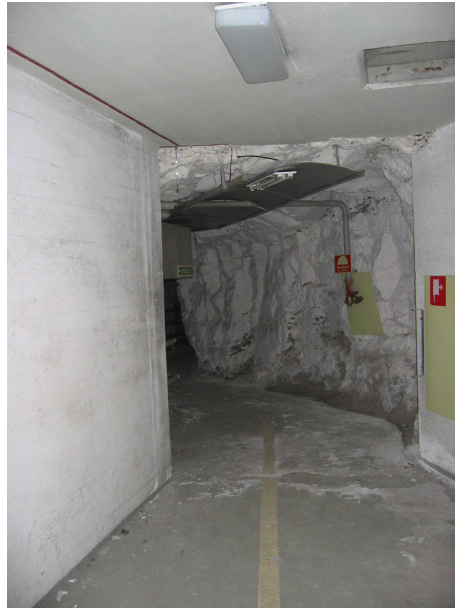
Figur 38 Gången från fjärrställverksbyggnaden in i bergrummet
