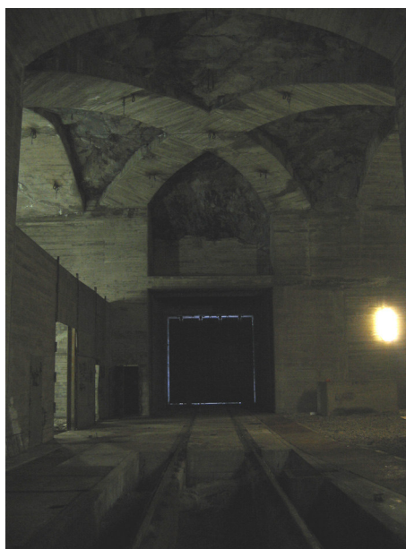
Figur 42 Maskinsalens yttre del med stenfilterportarna längst bak
