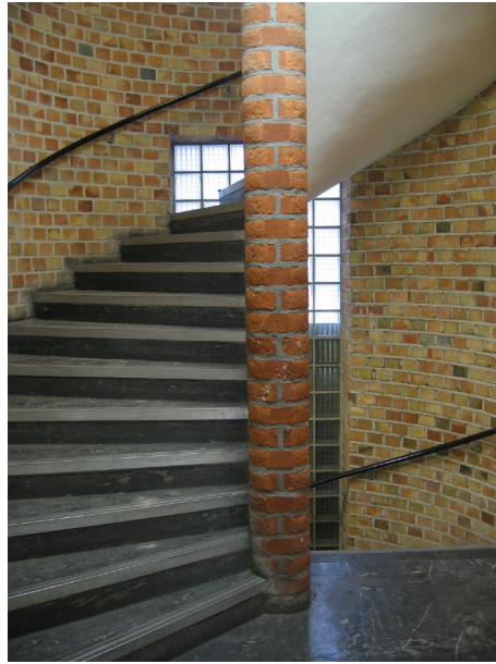
Figur 28 Trapphuset 107 med det vertikala bandet av glasbetong.
