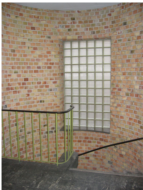
Figur 33 Trapphuset 204 med fönster av glasbetong och stålräcke.
