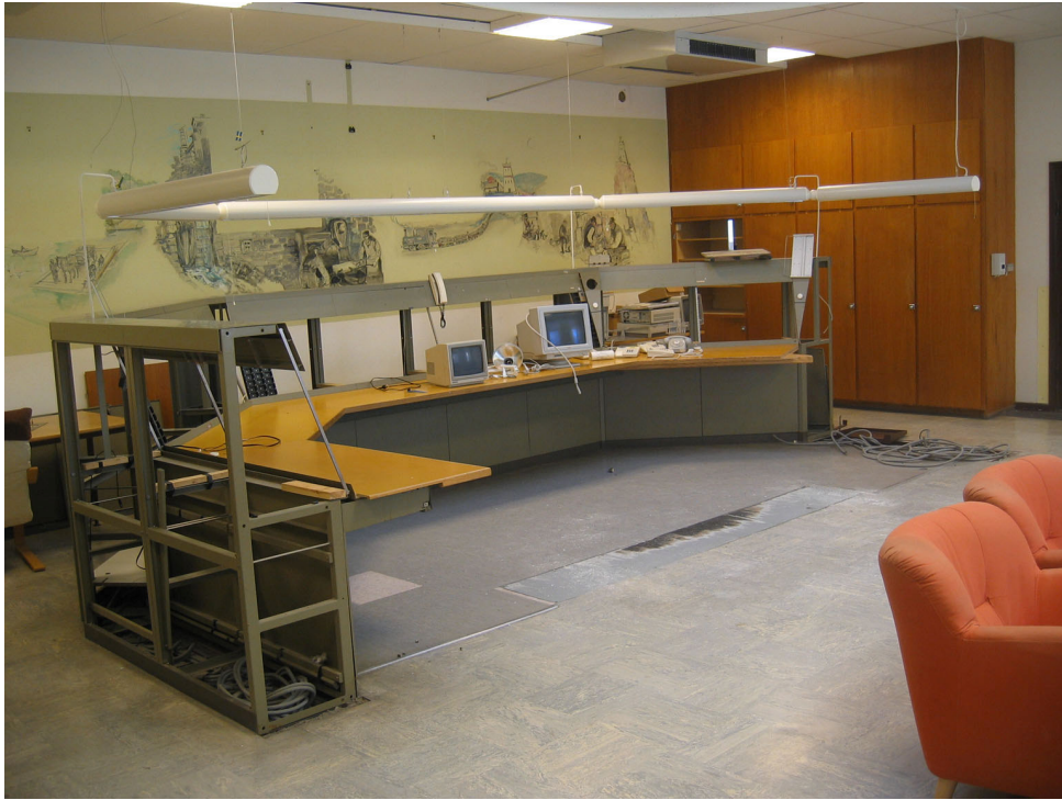
Figur 29 Tågledarens rum 201 med den demonterade ställverkspanelen och sentida data-skärmar – jämför med figur 4 och omslaget. På väggen fält med motiv från gruvhanteringen.
