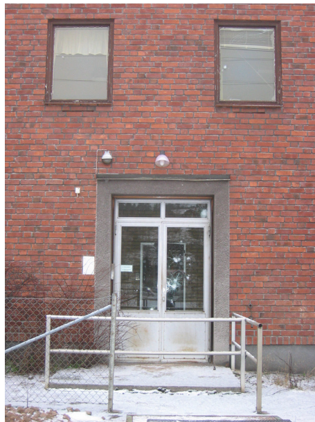
Figur 13 Huvudentrén – lampan ovanför dörren är original sen huset byggdes
