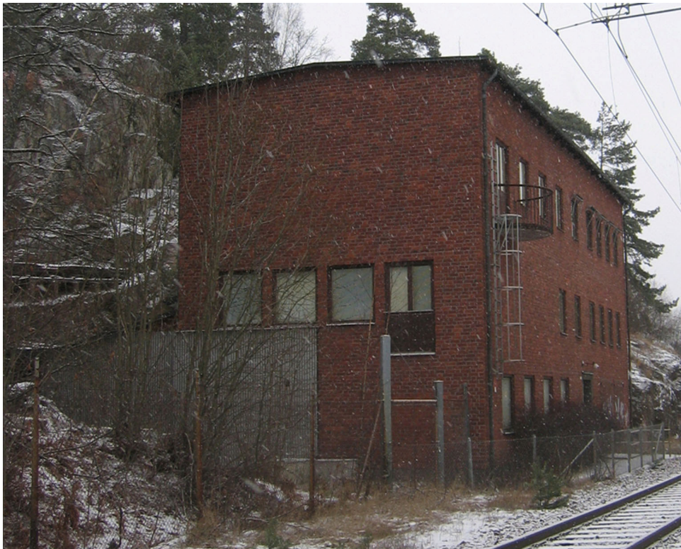
Figur 10 Fjärrställverksbyggnaden i Skogstorp sedd från söder. Jämför med figur 8.
