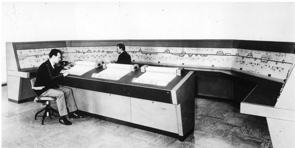
Figur 4 Interiör från tågledarens rum i Skogstorp något år efter invigningen. Fjärrställverksskärmen i bakgrunden med tidtabells-skrivaren närmast kameran. Jämför med figur 29. Foto Siemens arkiv, München
