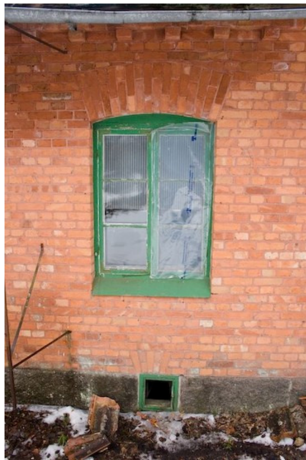
Fönstret i salen sett från fasad c
