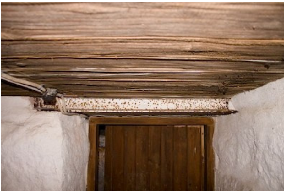
Järnvägsräler vilka bär murverket ovanför dörr- och fönstergluggar.
