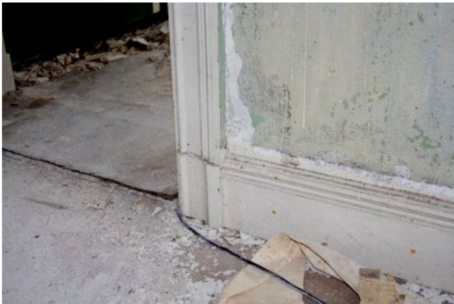
Golvlist av ursprunglig rikt profilerad modell.
