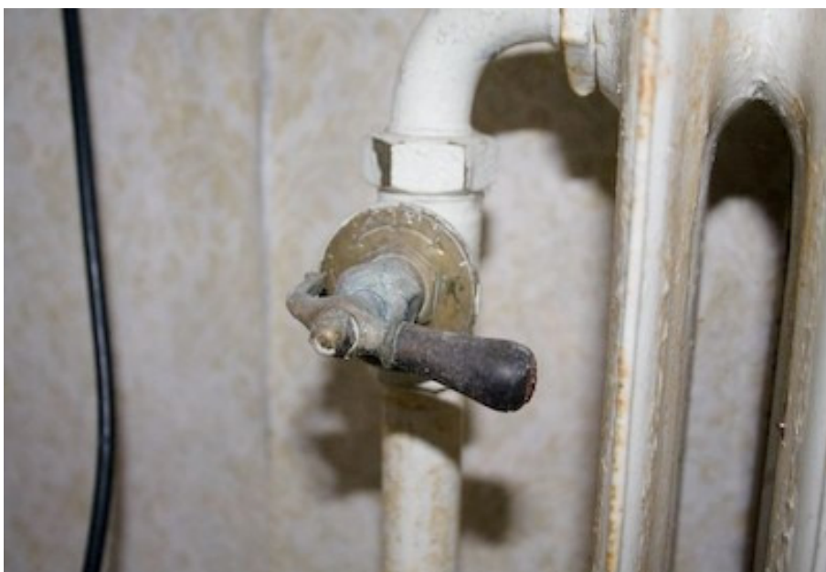
Mässingsventil av samma modell som finns på samtliga radiatorer.
