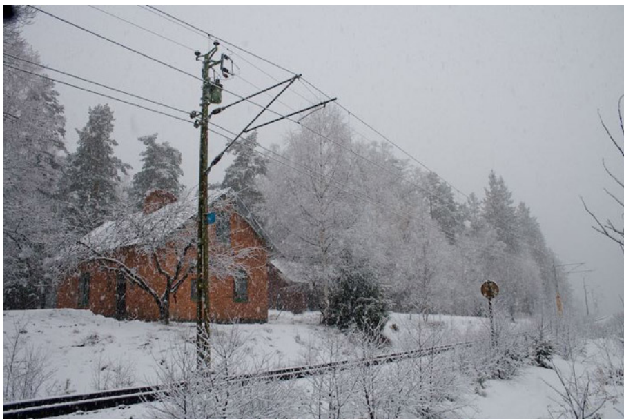
Banvaktstugan med den elektrifierade järnvägen utanför.
