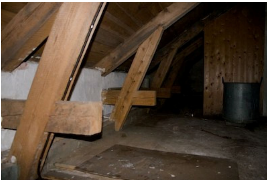
Delar av takstolskonstruktionen.
