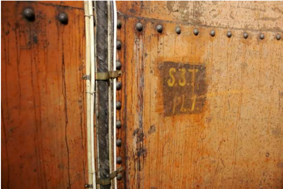
Elkablar vid den norra delen av tornets orange innervägg. Observera märkningen »S.3.T. PL.1.« på en av plåtarna som är ett exempel på hur man gjort i resten av byggnaden.
