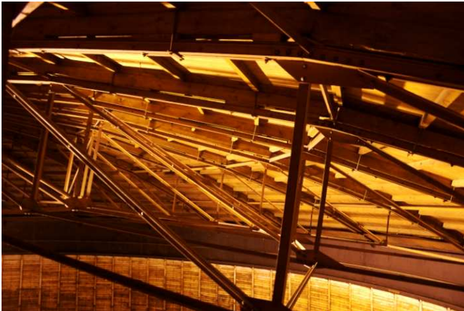
Takkonstruktionen med fackverkstakstolarna av järn.
