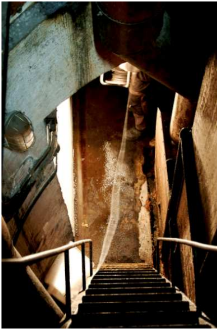
Trappan ned i källaren
