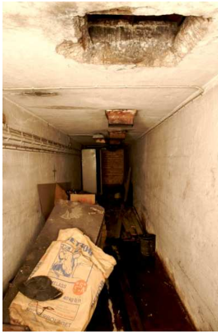
Tunneln i källaren sedd mot öster
