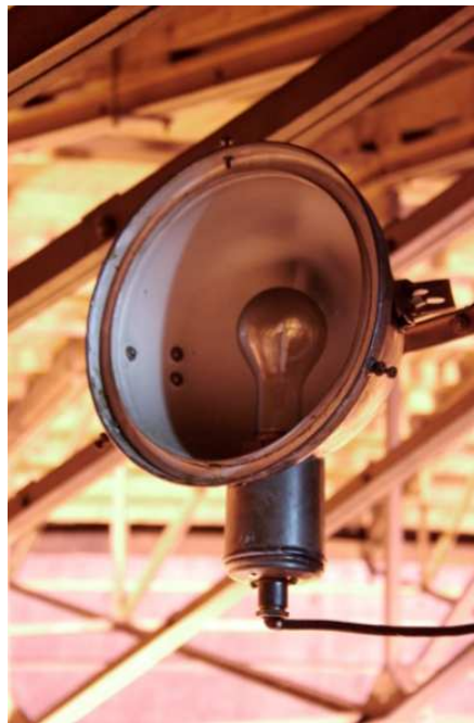
En av de fem bevarade s.k. intensivarmaturerna som finns i höjd med viadukten – den sjätte saknas.
