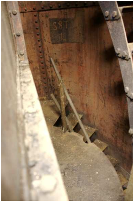
Spiraltrappan i tornet
